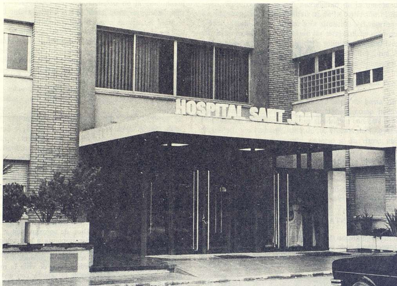
Hospital San Juan de Dios. Manresa
